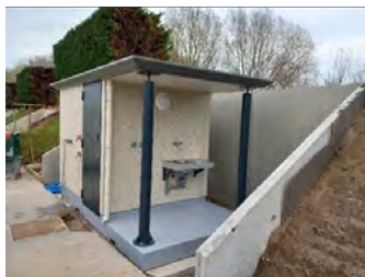
Bâtiment modulaire béton mis en place, à la suite raccordement réseau sec et humide
