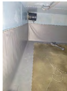
Réhabilitation liner bac tampon C2
