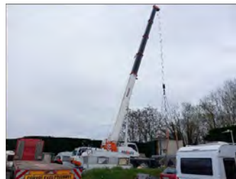
Installation grue mobile y compris contre poids et plaque de répartition
