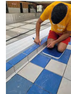
Reprise des joints et carrelage bassin (en régie)
