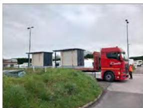
Installation camion porteur sur site
