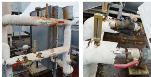
Figure 26. Calorifuge de la tuyauterie et des équipements vétustes
