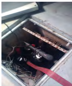
Poste de relevage Eu et armoire de commande
